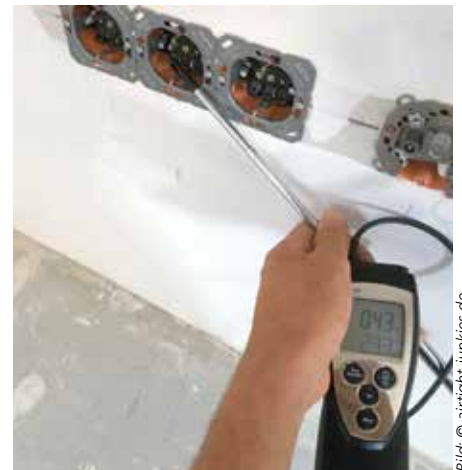
(2) Leckagesuche ist Pflicht. Sie ist auch in der Norm als Teil der Messung aufgeführt. Dies gilt ebenso für die neue Norm.
