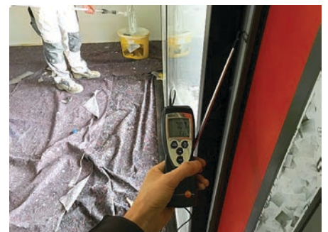
(7) Das Anemometer dient v. a. zur genauen Lokalisierung und Dokumentation bereits gefundener Leckagen. Auch die genaue Strömungsrichtung ist oft ausschlaggebend.
