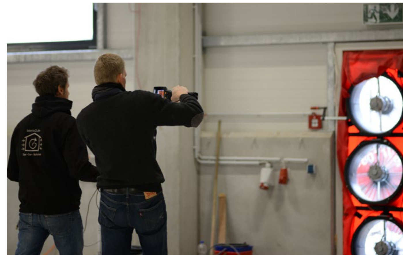
Da das Fördervolumen eines Blower-Door-Gebläses begrenzt ist, werden größere Gebäude meist mit mehreren Geräten gemessen. Hier bei einer 52.000 Kubikmeter großen, beheizten Halle in Bayern.
